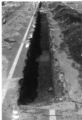
T3 遺構確認状況（東から）
