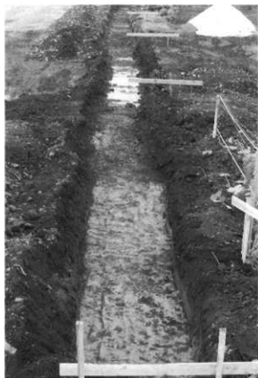
T 5 遺構確認状況 (東から)
