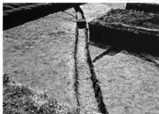
2号溝完掘(北東から)
