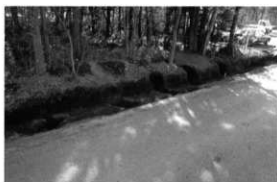
⑧SB60 完掘状況
