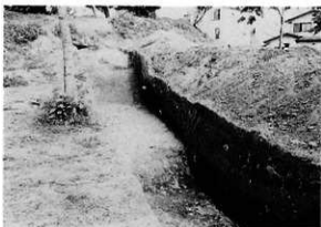
(3)T-2: 前部西側面完掘状態 (西から)
