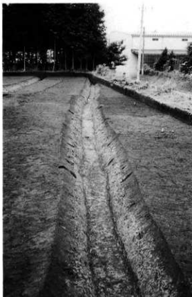
②SD03完掘状況（北より）
