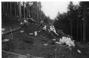
土塁の調査状況
