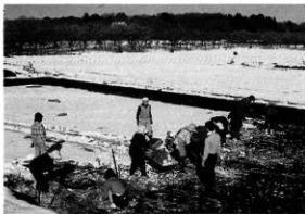
西地区の排土作業風景
