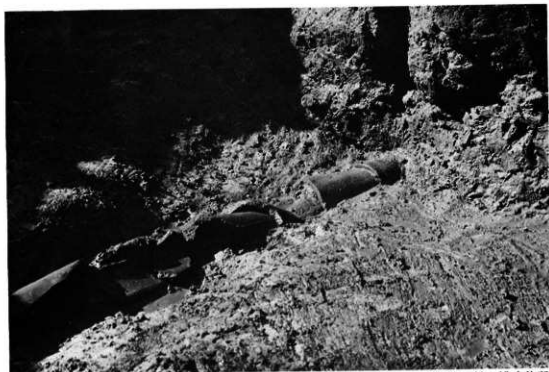
1号窯焚口外の排水施設
