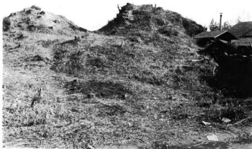
1 後門部発露前の状況
