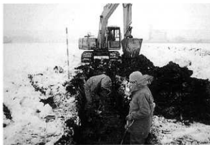
試掘作業風景 (1トレンチ)
