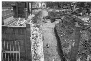
試掘 1 トレンチ (北から)
