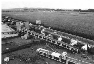
同左（南東から）
