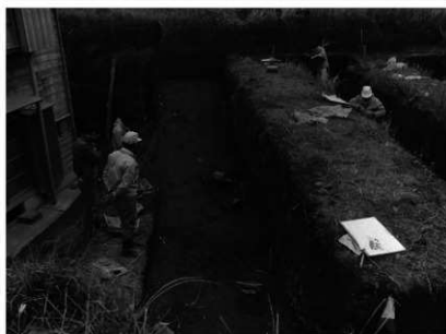
Mトレンチの調査状況（東側から）
