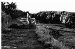
重機による表土除去作業
