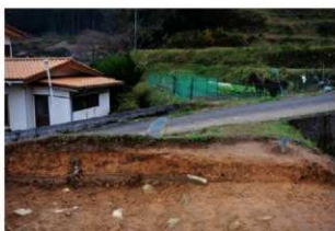
8 4地区北側東壁土層断面状況（西から）
