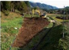
写真1 重機による表土除去
