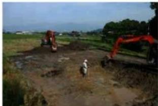
写真 1 重機による表土除去
