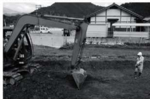
重機による表土除去
