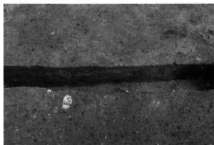
4. VF-12断面 SW→
