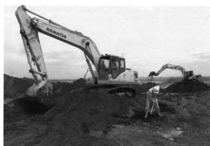
3. 包含層除去状況 (SW→)
