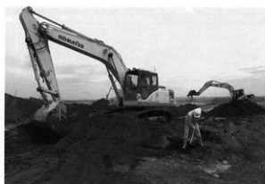
3. 包含層除去状況 (SW→)
