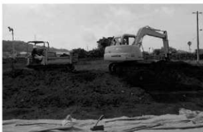
重機掘削風景
