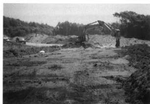
重機による遺構検出作業（北西から） 第1次立会区域A区。
