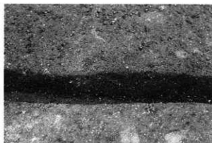
2. VF-01断面 S→
