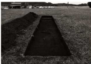
29T遺構確認状況 (西から)
