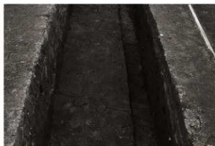
SK148確認状況 (2) (北から)
