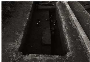
SK154・SD9確認状況（南から）
