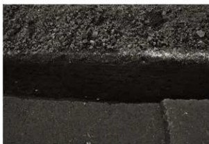
第6トレンチセクション (2) S K 15付近 (東から)
