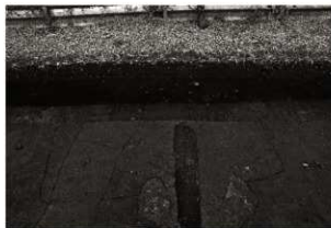
S I 2セクション (東から)
