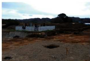
第4 調査区北部完掘状況(南西方向から)
