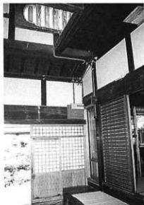
35. 土間上部の梁組
