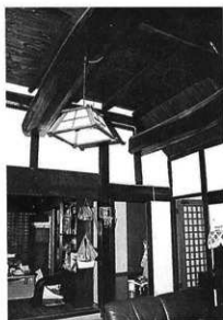
21. 土間上部の梁組
