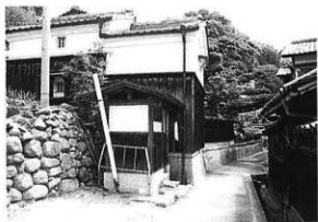
31. 岡田家土蔵の外観
