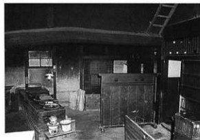
59. 土間裏手の勝手まわり
