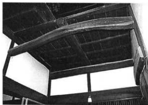
29. 土間上部の梁組
