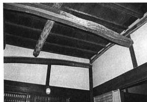
46. 土間上部の梁組
