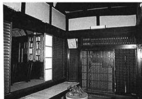
34. 土間入口まわり
