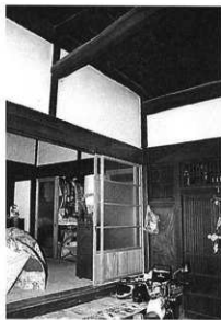
28. 土間入口まわり
