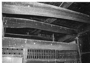
51. 土間上部の梁組
