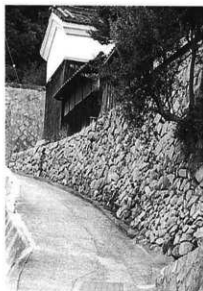
2. 擁壁状に造成された宅地例 (免山 篤家)
