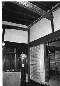
45. 土間入口まわり
