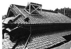
42. 主屋背面外観
