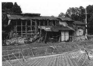
写真2 寒天小屋 裏から
