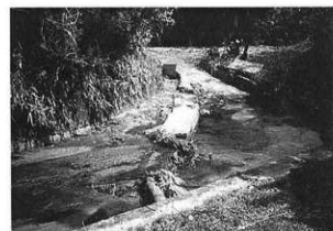
下代水路の井堰（塩田川）
