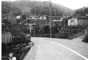
写真18 清溪地区の建築資材置場
