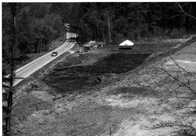
2. 厚幌1遺跡 近景 (SW→)
