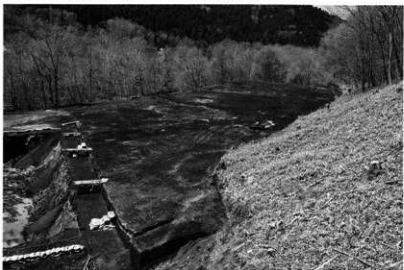
3. 平成28年度 A区調査前 E→
