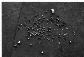
7. VPB-30検出(1) N→
