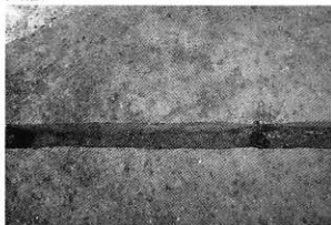
1. VF-14検出 SW→
