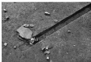
1. VF-10検出 SE→
