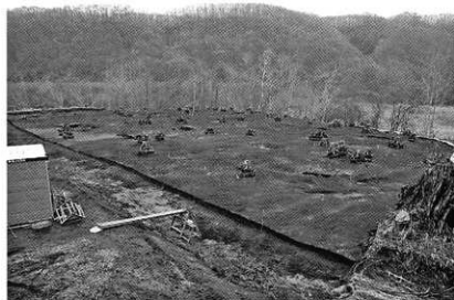
3. 調査区近景(平成23年度調査区) SW→
