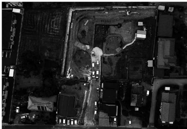
調査区全景（上が東）
