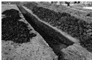
8トレンチ (南西より)
