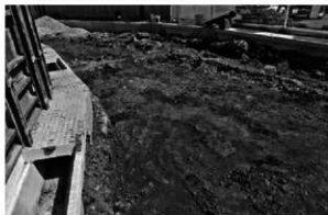
調査区西端 工事立会い状況
