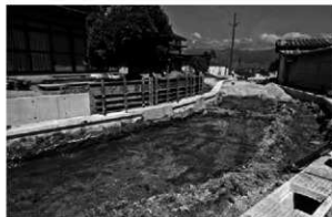
調査区西端 工事立会い状況
