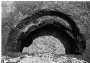
SK78完掘状況（北上から）
