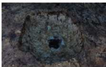
SP04柱の当たり (西から)
