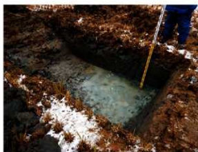
7号トレンチ調査状況 (南→)
