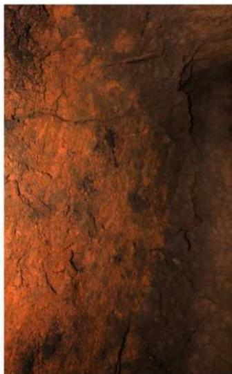
同 東壁～天井の掘削痕
