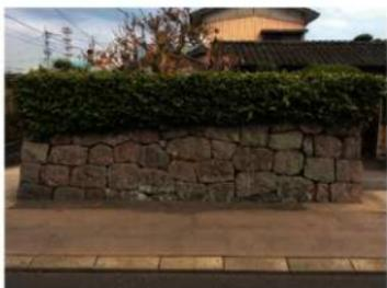
第96図 打ち込み剥ぎ乱積み
