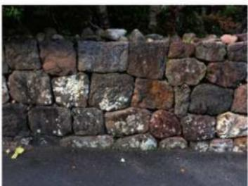
第95図 打ち込み剥ぎ布積み
