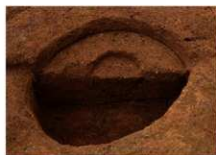
2. S11・P1 断面 (南から)
