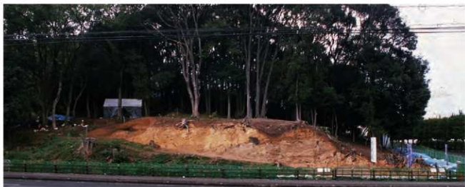
(1) 切通し部全景 (東から)
