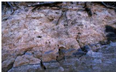
(1) 切通し部中央部 (東から)
