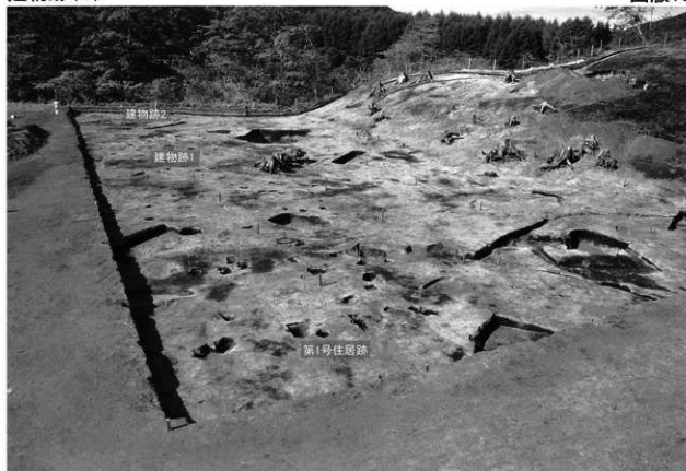
1. IIIH-01, 建物跡1,2柱穴検出状態 (E→)
