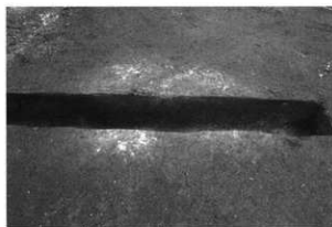
5. ⅢF-244断面 (SE→)
