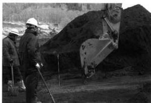
1. 平成19年度火山灰除去状況
