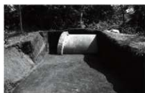
燃料倉庫検出状況
