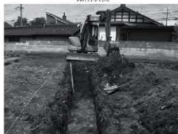
遺構出土状況
