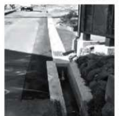
195-2 金井遺跡2 施工状況
