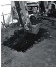
浄化槽設置箇所 掘削状況
