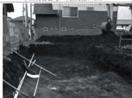
掘削・遺構出土状況
