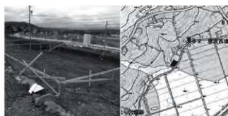
36 唐沢道跡3 掘削状況・位置図
