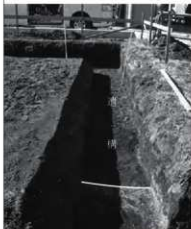
遺構出土状況
