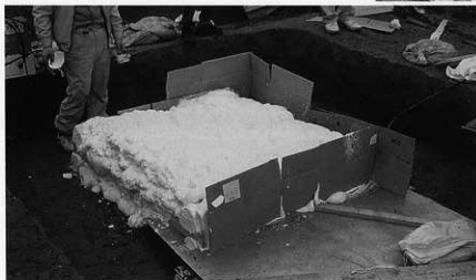
5. ポリウレタン吹き付け作業
